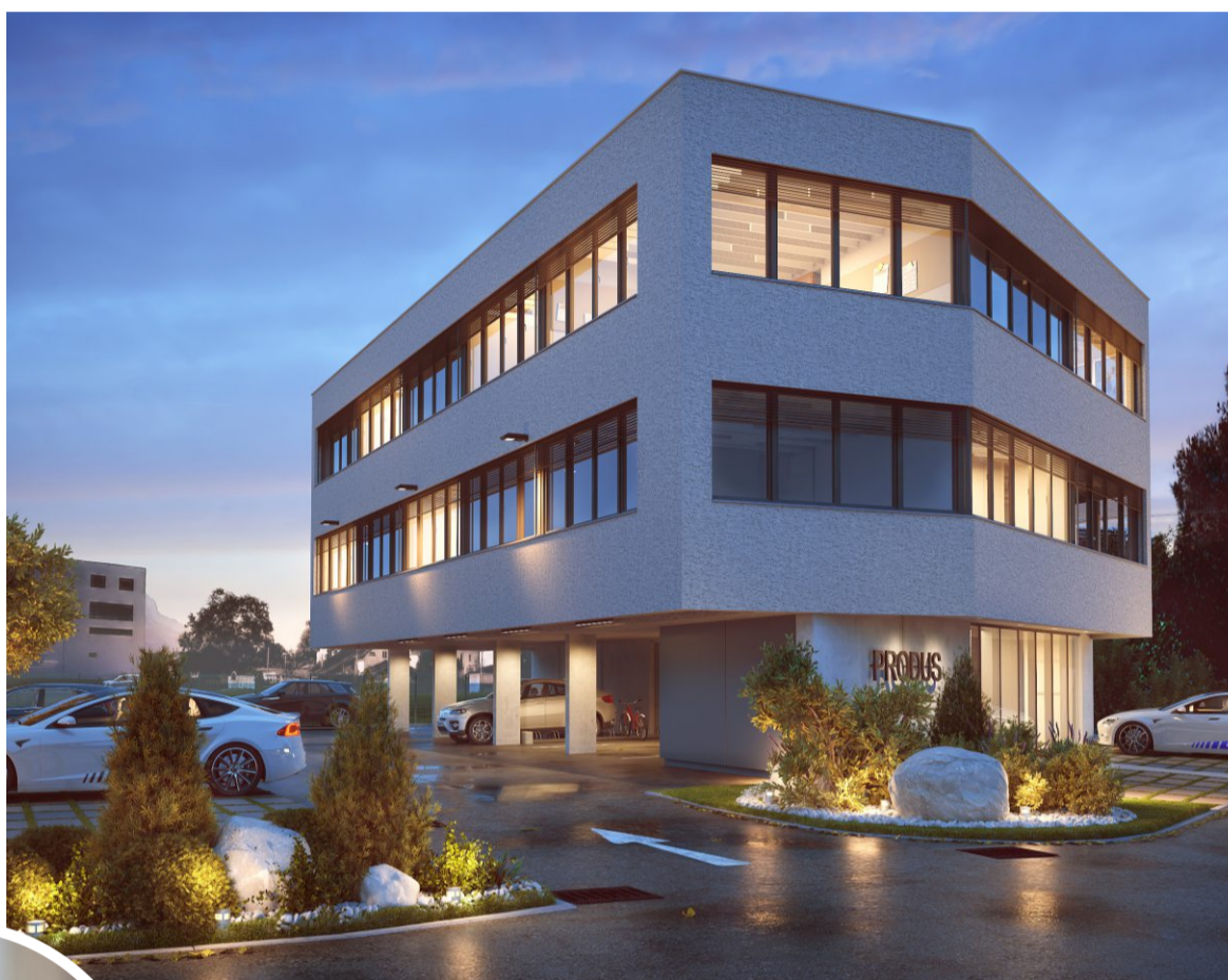
Das Unternehmen errichtet neuen Firmensitz in Koblach mit Platz für weitreichende Expansion.
